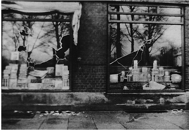
Durch einen Anschlag beschädigte Verteilungsstelle in Hamburg 1932
