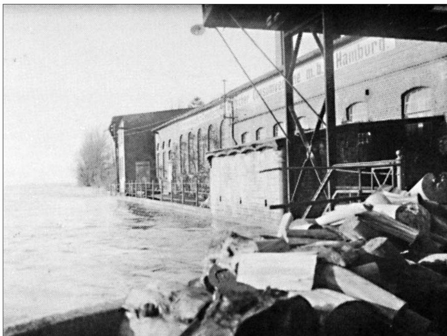
Abbildung 6 Das alte Fabrikgebäude der GEG vor dem großen Brand während einer bedrohlichen Hochwassersituation (vermutlich 1920 oder 1926)
