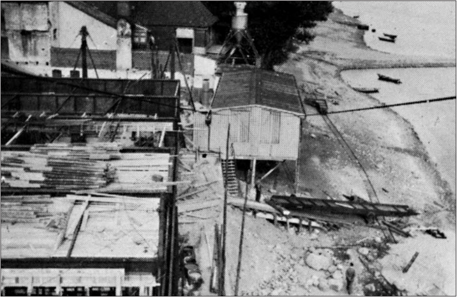
Abbildung 7 d Der Neubau schreitet voran. Die im rechten Bildrand sichtbaren Schienen des zum Holztransport benutzten Lorenweges wurden nur für die Bauzwecke so nahe an die Elbe verlegt. Sie befanden sich ursprünglich weiter oberhalb.
