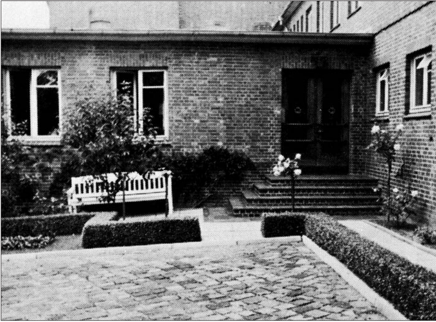
Abbildung 13 Neues Kontor und Sozialgebäude der GEG 1952
